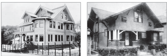
建築家小笹三郎がアメリカから導入したプラット・フォーム構造で建てた小野友次郎邸(明治45年)。「あめりか屋」の橋口信助が輸入し、販売・建設した住宅(明治43年～)。
