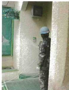
外装塗り替え作業
