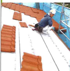
屋根の葺き替え作業
