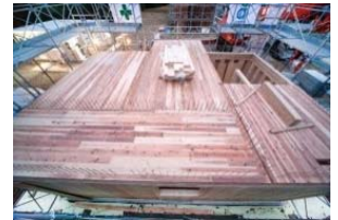
2階CLT床(工事中)
