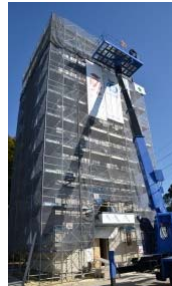
実験棟(工事中)
